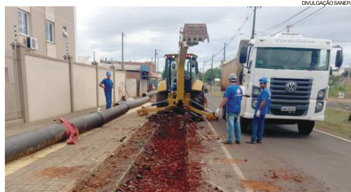
Obras ampliam rede de distribuição de água
