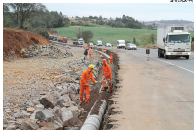
No trecho entre Cascavel e Capitão, frente de trabalho é reduzida e no canteiro há o temor de paralisação
