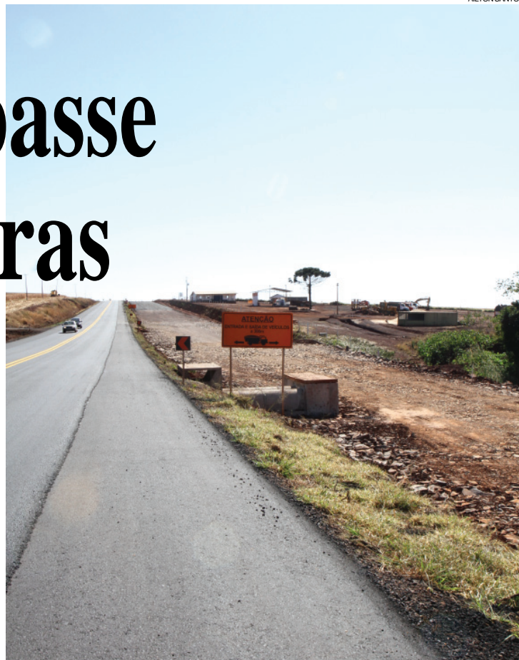
Duplicação dos 38,9 quilômetros entre Toledo e Marechal Cândido Rondon segue totalmente parada
