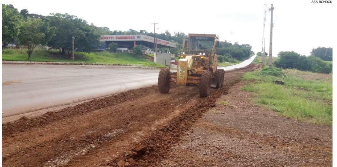
Trabalhos foram iniciados ontem na região próxima a Quatro Pontes. Mais segurança aos motoristas
