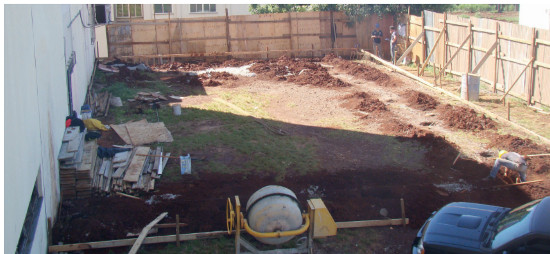
Construção de quadra de esportes foi iniciada
