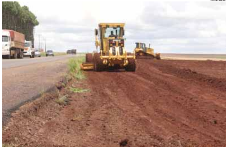
Equipes realizam serviços de terraplanagem e limpeza para duplicação da BR-163, num trecho de 15 km
