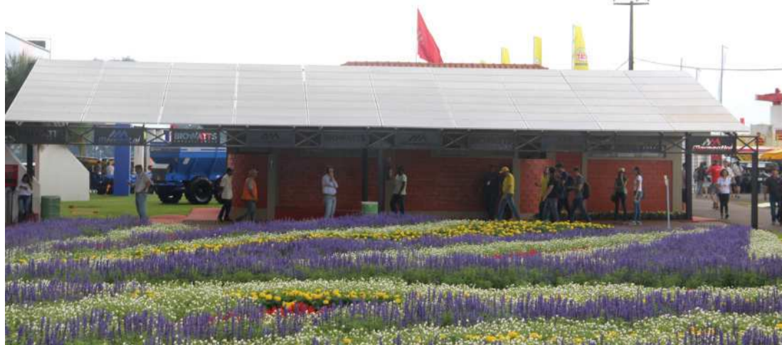
Placas foram instaladas sobre edificações no parque tecnológico
