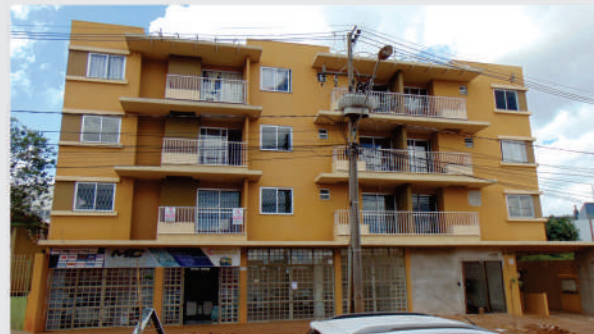
SALAS COMERCIAIS: Alto Alegre - Rua Vitória, Ed. Vitória, próximo a OAB. São 6 salas comerciais de 26m² até 59m². Valor de locação sob consulta.
