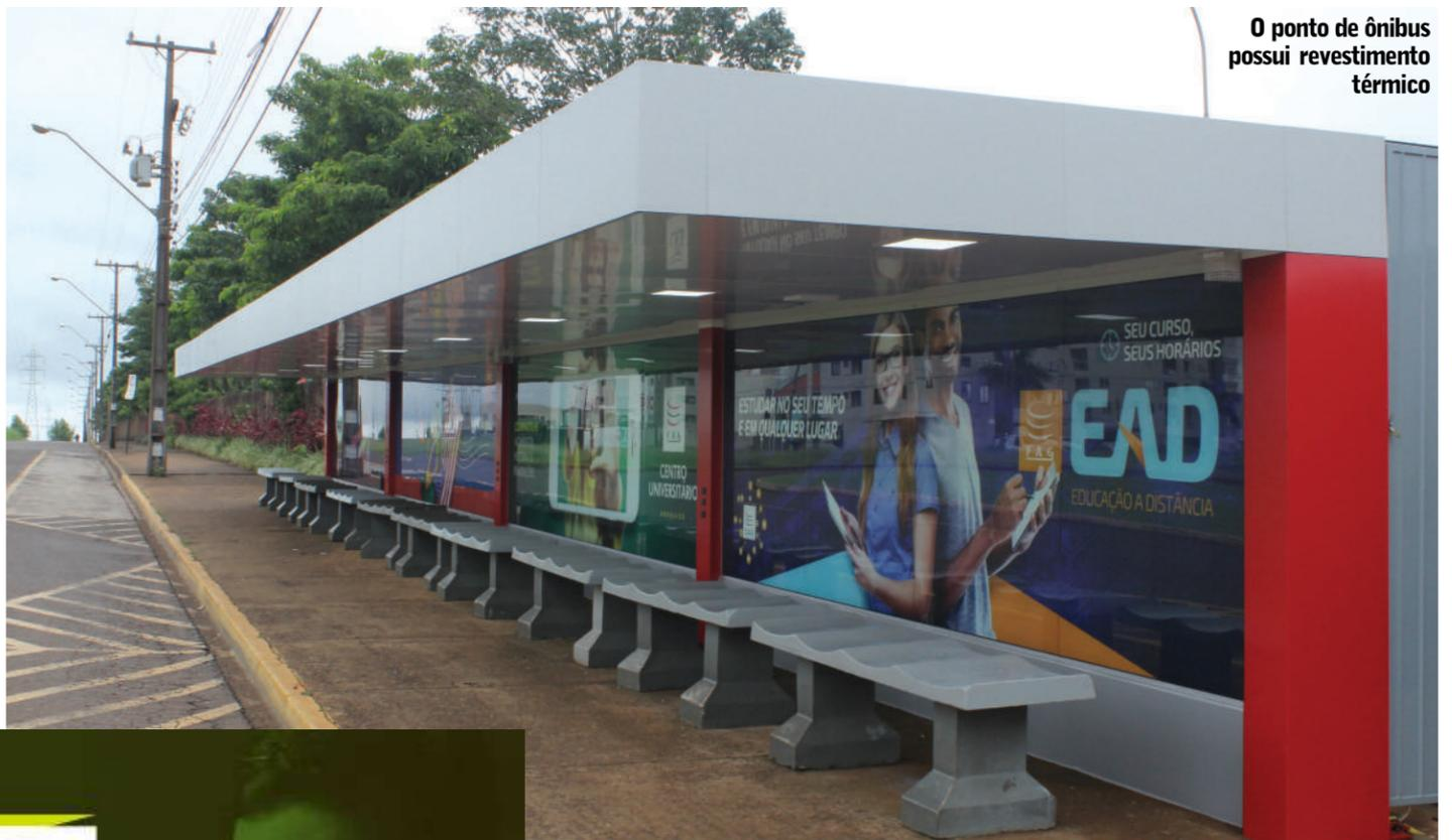
**O ponto de ônibus possui revestimento térmico**
