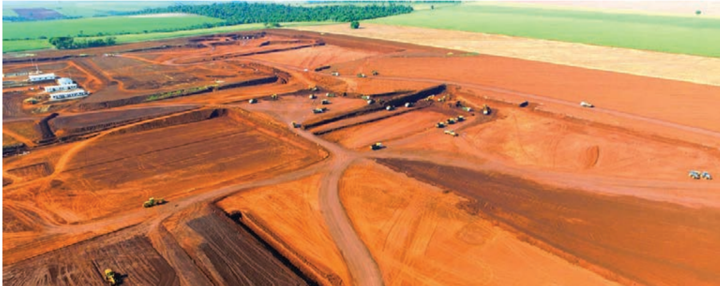
Obra do novo frigorífico parou ainda na terraplanagem e na fundação
