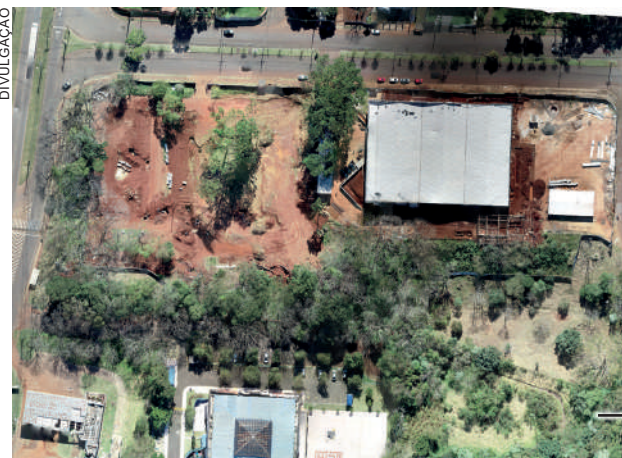
Nova entrada do PTI, vista de cima
