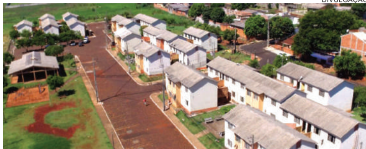
Em Foz, condomínio que custou R$ 6 milhões foi evacuado para ser demolido
