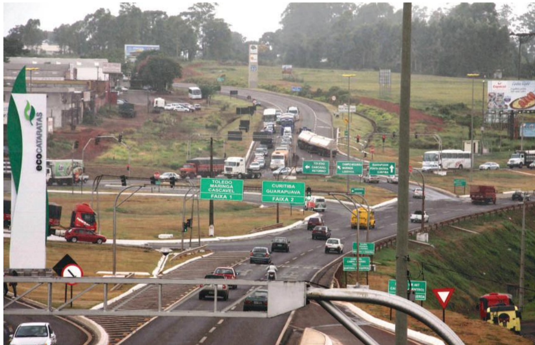
Readequação do Trevo Cataratas é uma das obras prioritárias
