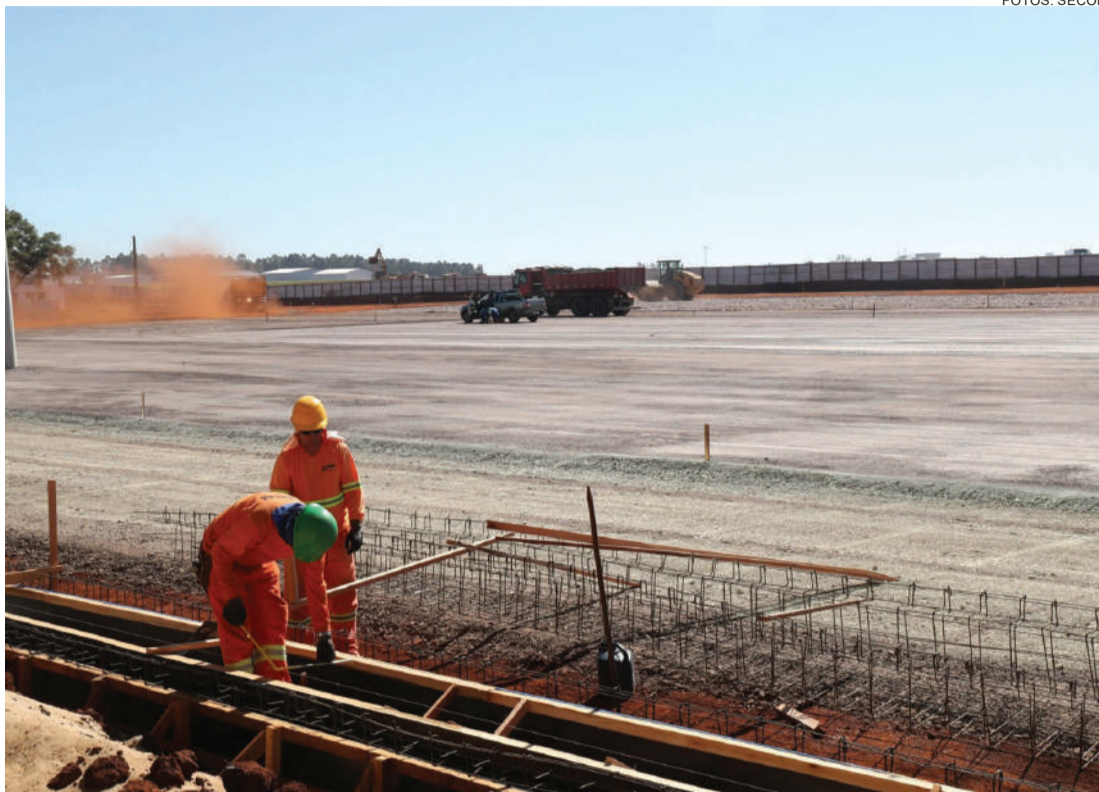
Pátio de aeronaves está 25% concluído
