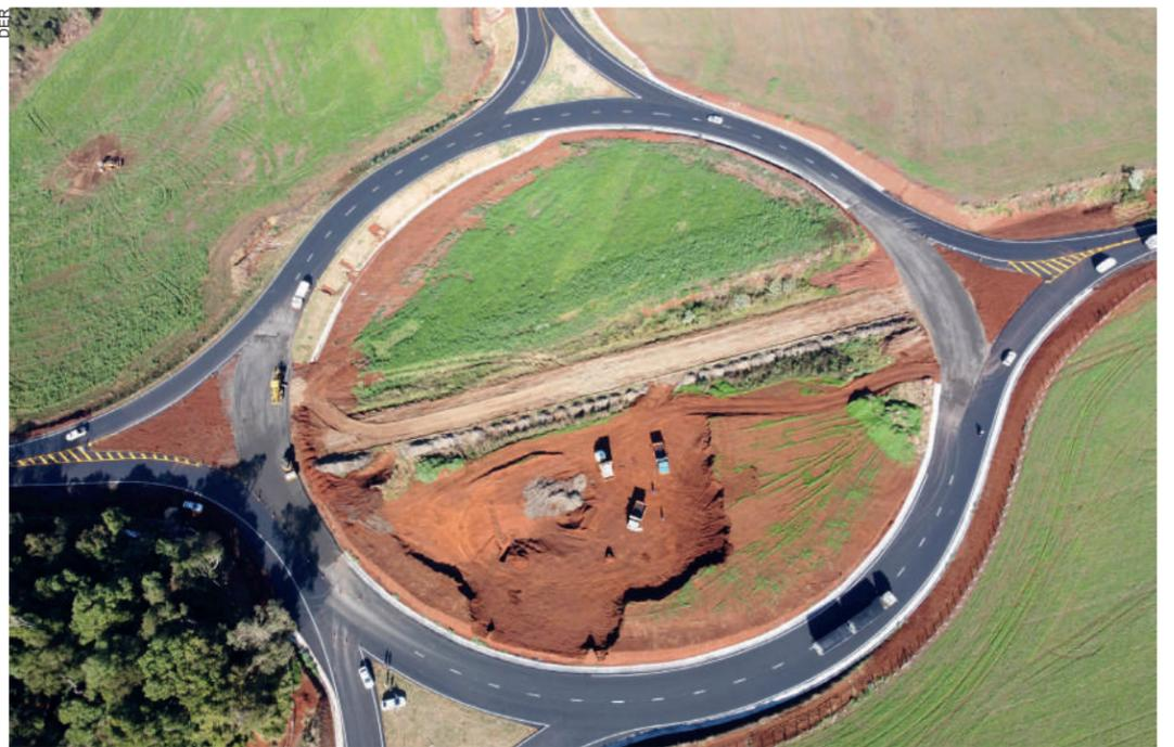
No atual estágio da obra, ainda resta plantação de grama e árvores, asfalto no trecho final da rotatória e em cima do viaduto, sarjeta, meio-fio e o acabamento, com sinalização vertical e horizontal.
