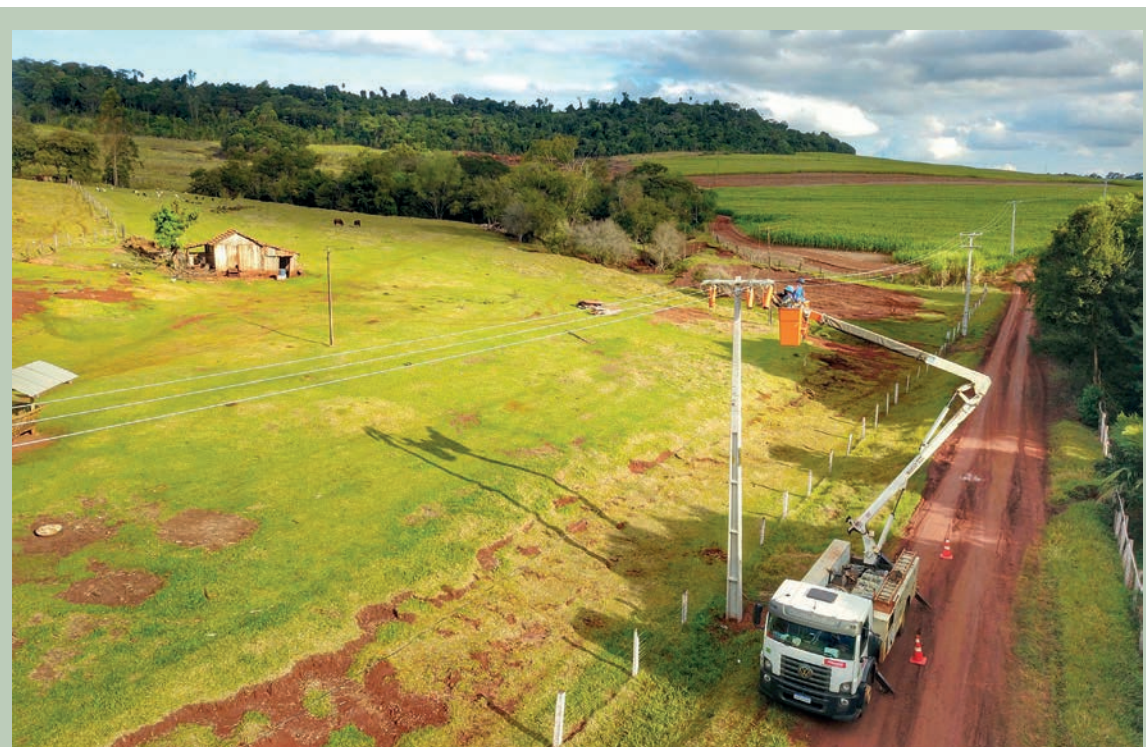
Outros 3,4 mil km já estão em execução
