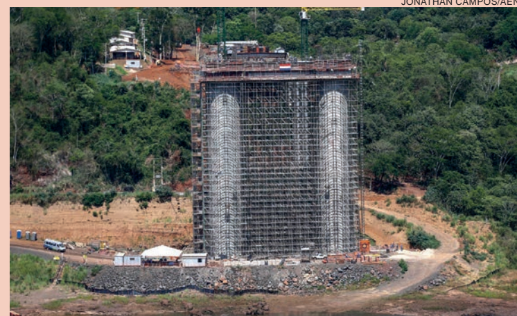
Bases da ponte avançam de cada lado do rio
