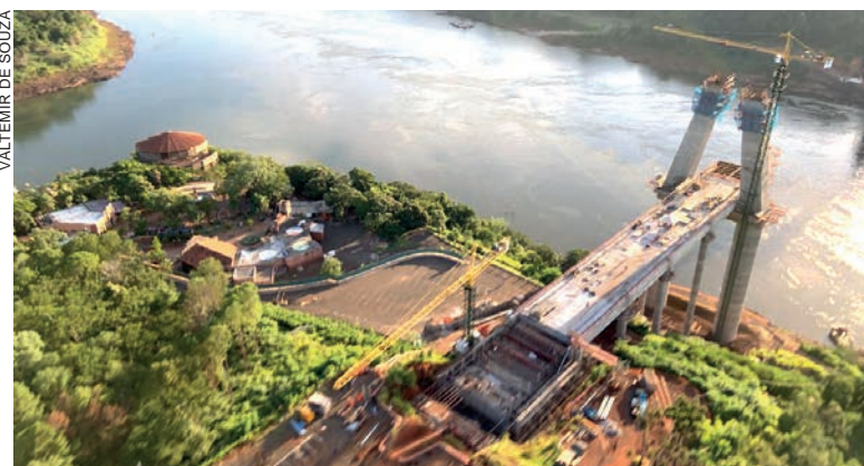
Ponte chegou a 46% da obra executada
