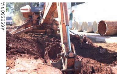
Os trabalhos de drenagem devem ser concluídos nas próximas semanas
