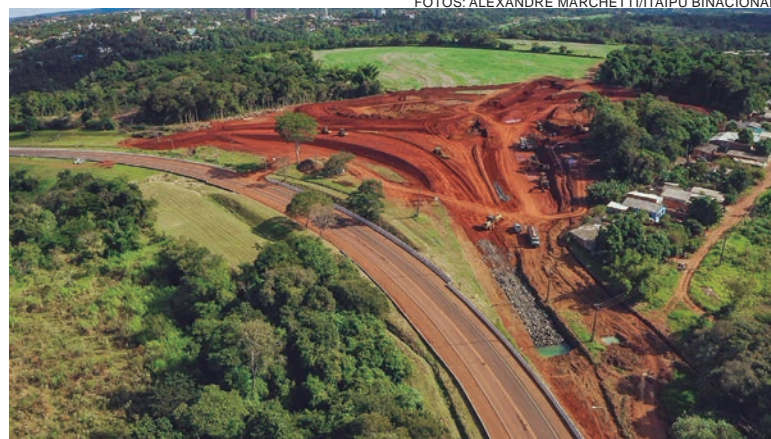
Até o momento, 2,3% da obra da Perimetral Leste está executada
