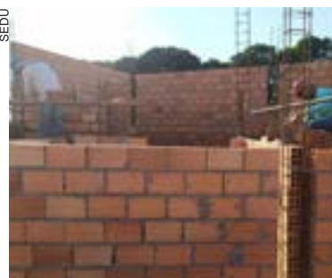
A obra já está em andamento, com cerca de 17% executada
