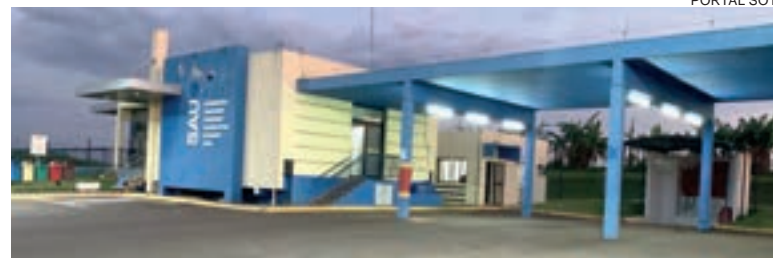
Estrutura para atendimento a ocorrências na área de responsabilidade da Viapar ficou comprometida
