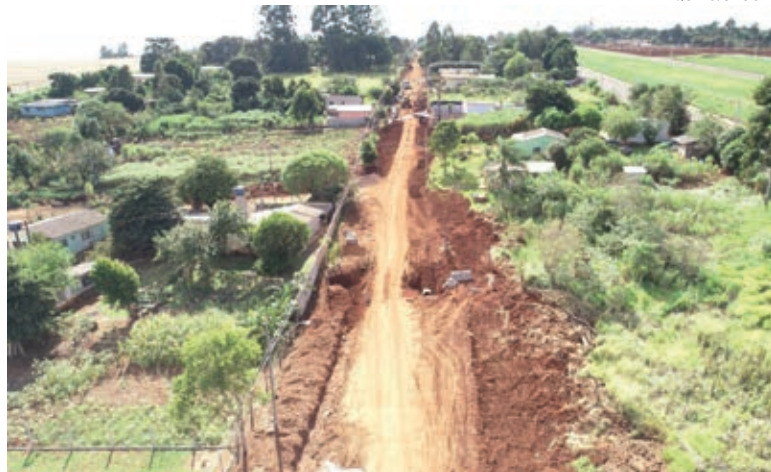
Registro do início das obras, em março de 2020; obra avançaram cerca de 30% e promessa é que serão retomadas
