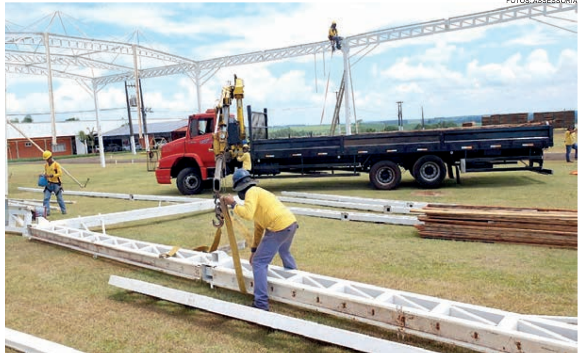
Cerca de 80 montadoras vão preparar os espaços que serão utilizados pelos 400 expositores confirmados
