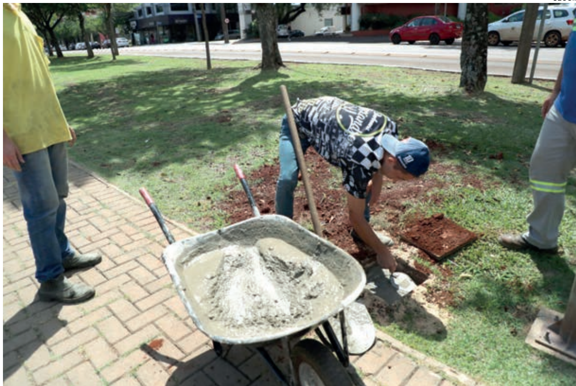
Funcionários da Sesop fazem a concretagem das caixas para evitar furto de cabos de energia elétrica
