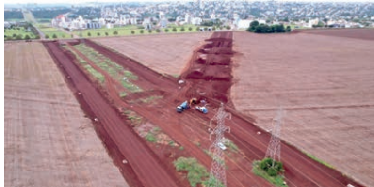
Terraplanagem da Avenida Brasil até a Avenida das Torres já está pronta
