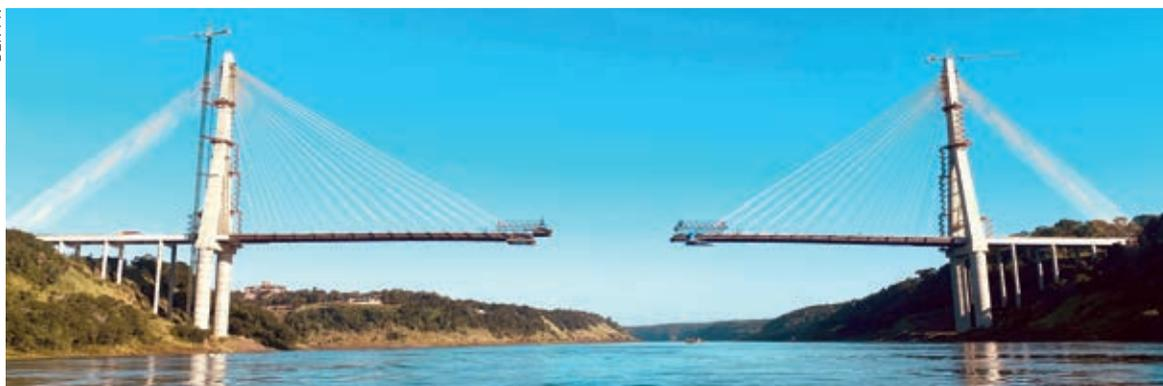
a colocação das lajes e concretagem sobre a aduela 5.13, lançamento da aduela 5.14 no vão central da ponte, e tensionamento do 13º par de estais na direção do rio. No canteiro da obra estão em pré-montagem as aduelas 5.15 e 5.16.
