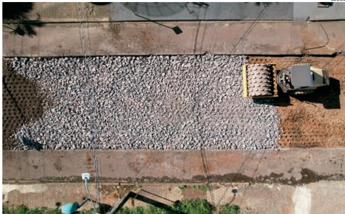
Rua Salgado Filho, no centro de Cascavel, teve toda sua base refeita, para receber nova pavimentação
