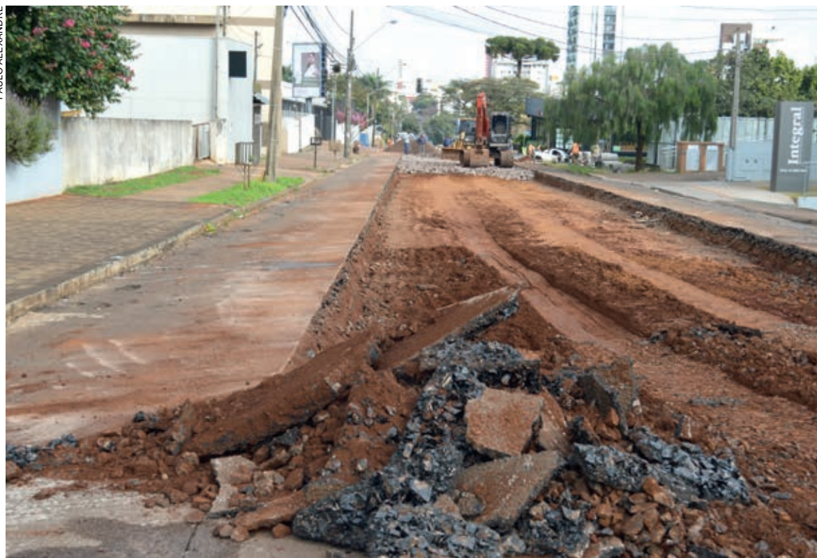
Na Rio de Janeiro, os trabalhos de ‘reconstrução’ do pavimento estão em execução
