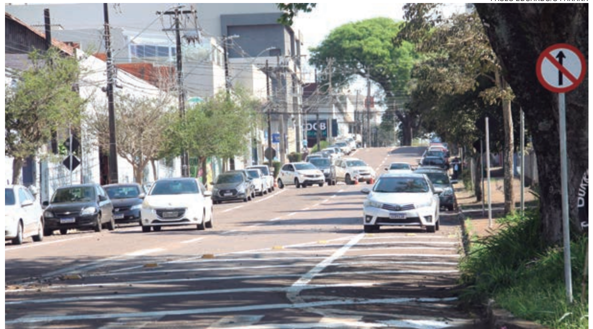
Alterações no trânsito na região central já estão funcionando, mas as obras ainda não foram iniciadas
