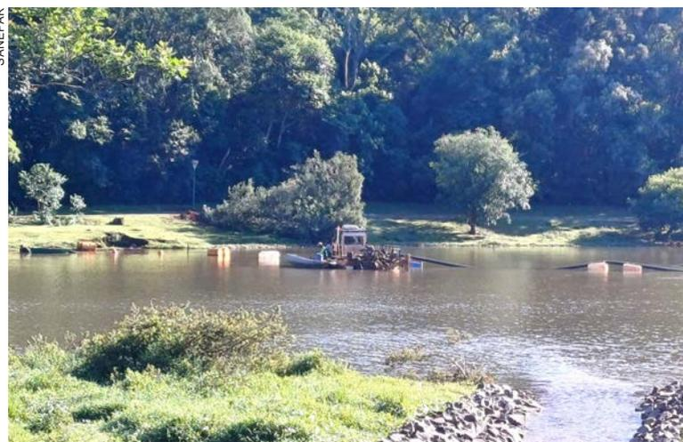
ambiental; preparação da área no Cascavel Velho para recepção do material dragado; instalação e testes da tubulação de transporte dos resíduos; montagem do canteiro e instalação dos equipamentos de dragagem; sucção dos sedimentos do lago; e instalação da proteção das encostas (rip rap) e das contenções nas entradas de água do lago.
