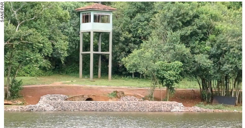
Draga que fez parte do cenário do lago durante o ano já foi desmontada, bem como os 3,5 mil metros de tubulação
