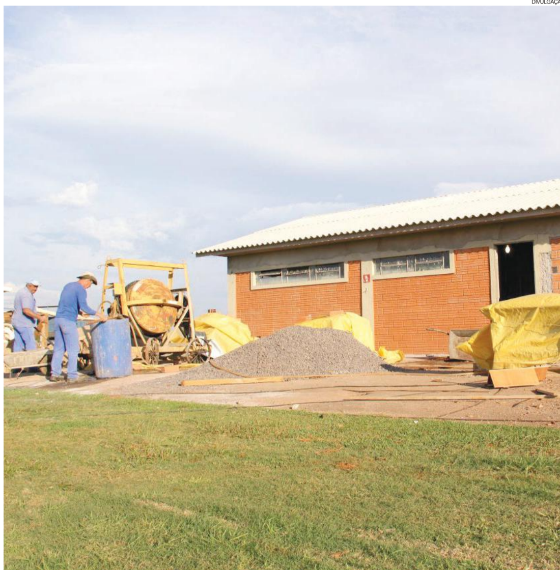
Trabalho intenso no parque reestrutura espaço para o evento em 2019
