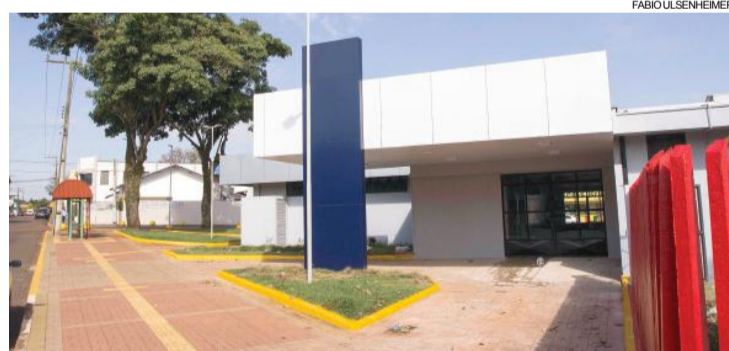
Unidade já está com 70% das obras concluídas
