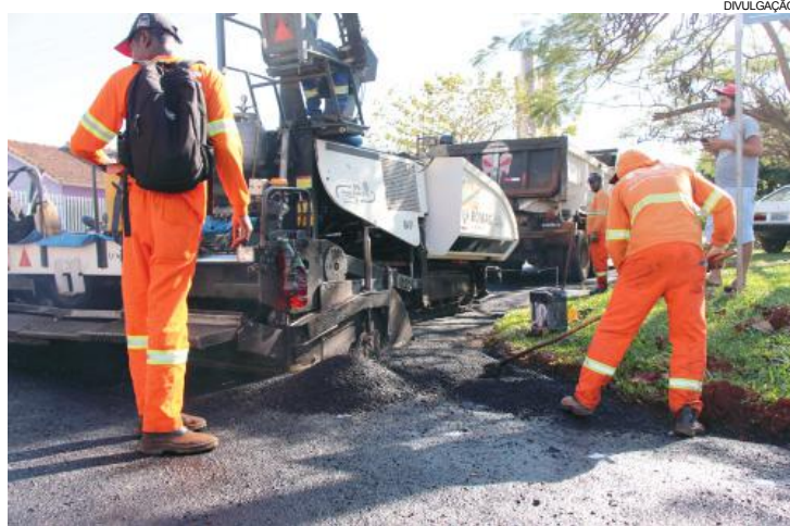
Aos poucos, obras mudam realidade de bairros
