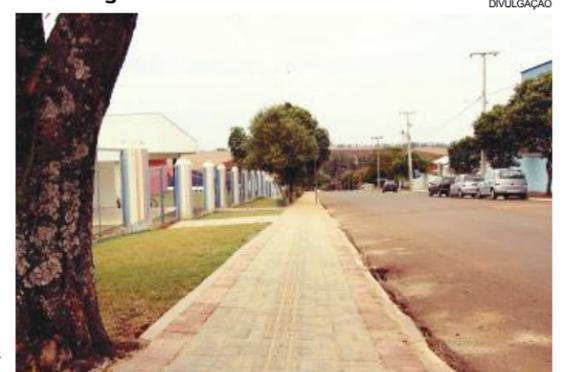
em Maripá. Cerca de 300 metros quadrados de calçada em paver foram executados no local, substituindo a calçada em concreto, que estava em condição precária e dificultava o acesso. A calçada conta com rampas de acesso para cadeirantes. A obra já está concluída e recebeu investimento de R\$ 25.150,72, custeados com recursos próprios.
