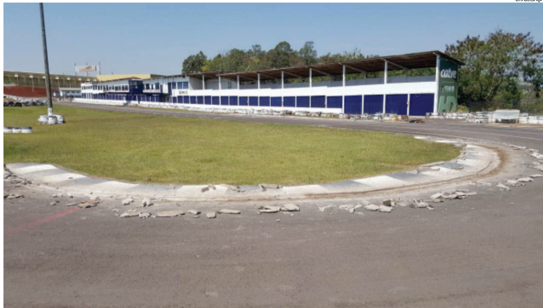
Toda a área de boxes recebeu nova pintura e zebras estão sendo reformadas e novas sendo construídas
