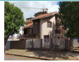
LINDO SOBRADO NO CENTRO - com terreno de 800 m² e sobrado com 276 m² 1 suite 3 quartos, sala com lareira, mais 2 salas de estar e de jantar, cozinha, lavabo, escritório, lavanderia, dep de empregada, 2 vagas. R$ 1.350.000,00.
