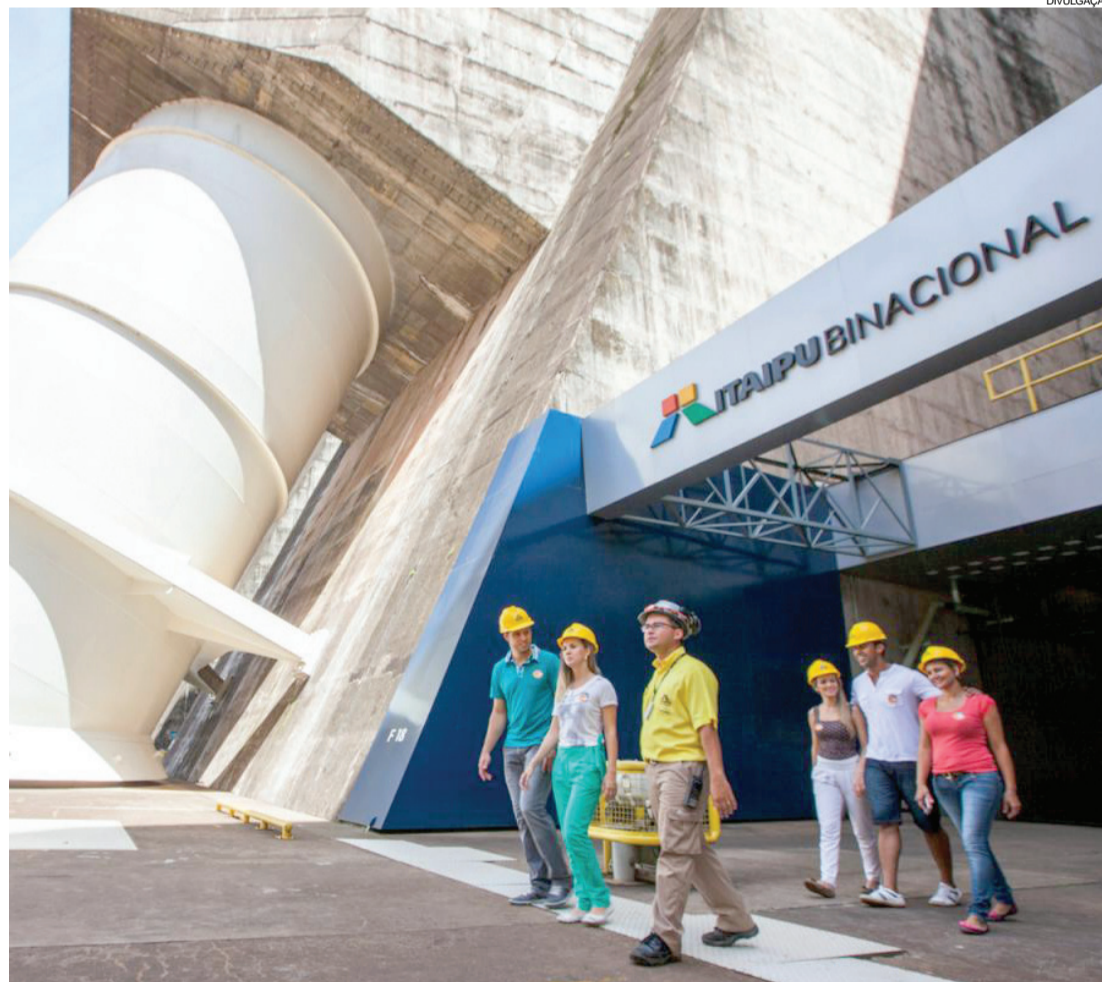
Equipes que atuam na Usina Hidrelétrica de Itaipu também vão participar do seminário em Foz
