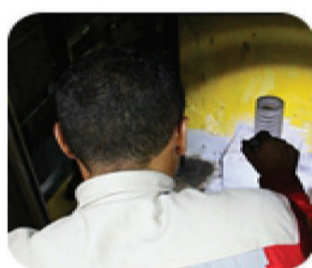
Casas de máquinas de elevador
