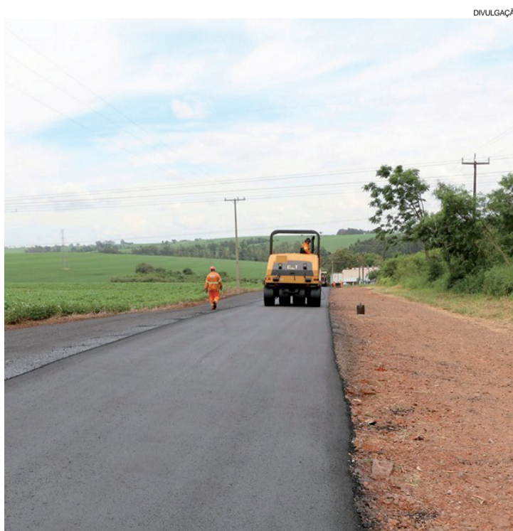
Melhorias foram feitas no trecho para garantir melhores condições de acesso e fluxo de cargas
