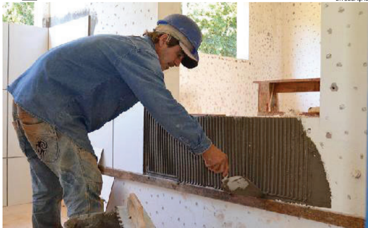
Empresa responsável pela obra estava assentando azulejos, construindo muro e trabalhando no projeto elétrico na UBS
