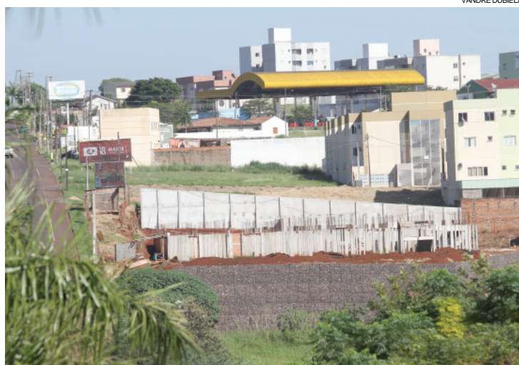
Obras estão paradas há quase um ano
