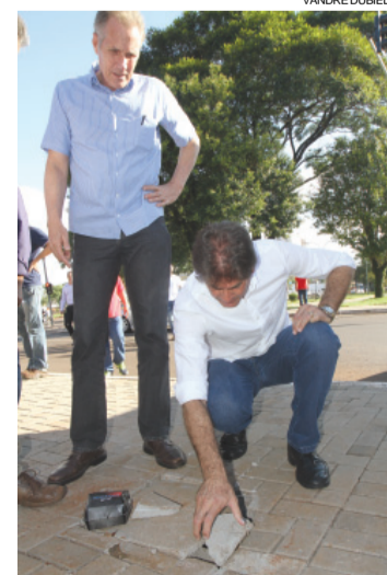
Muitos problemas foram encontrados em trecho recém-liberado da Avenida Brasil
