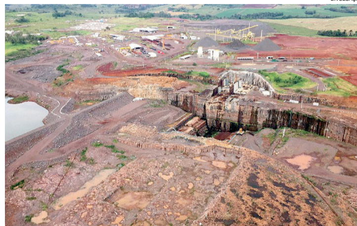
A usina está em construção no rio Iguaçu. Quarenta e cinco por cento do cronograma já foi vencido. Obra custará R$ 1,7 bilhão
