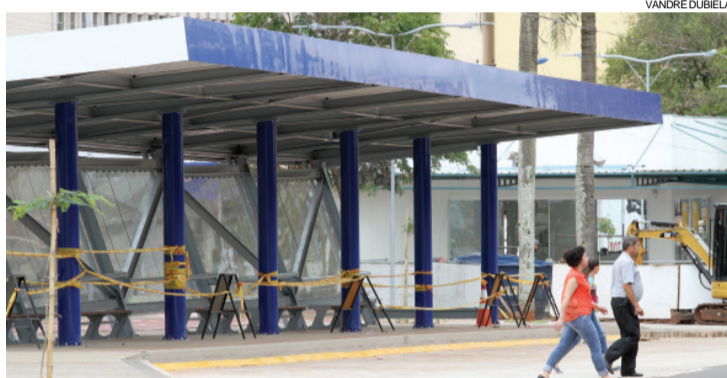
Novas estruturas de embarque foram instaladas na Avenida Brasil
