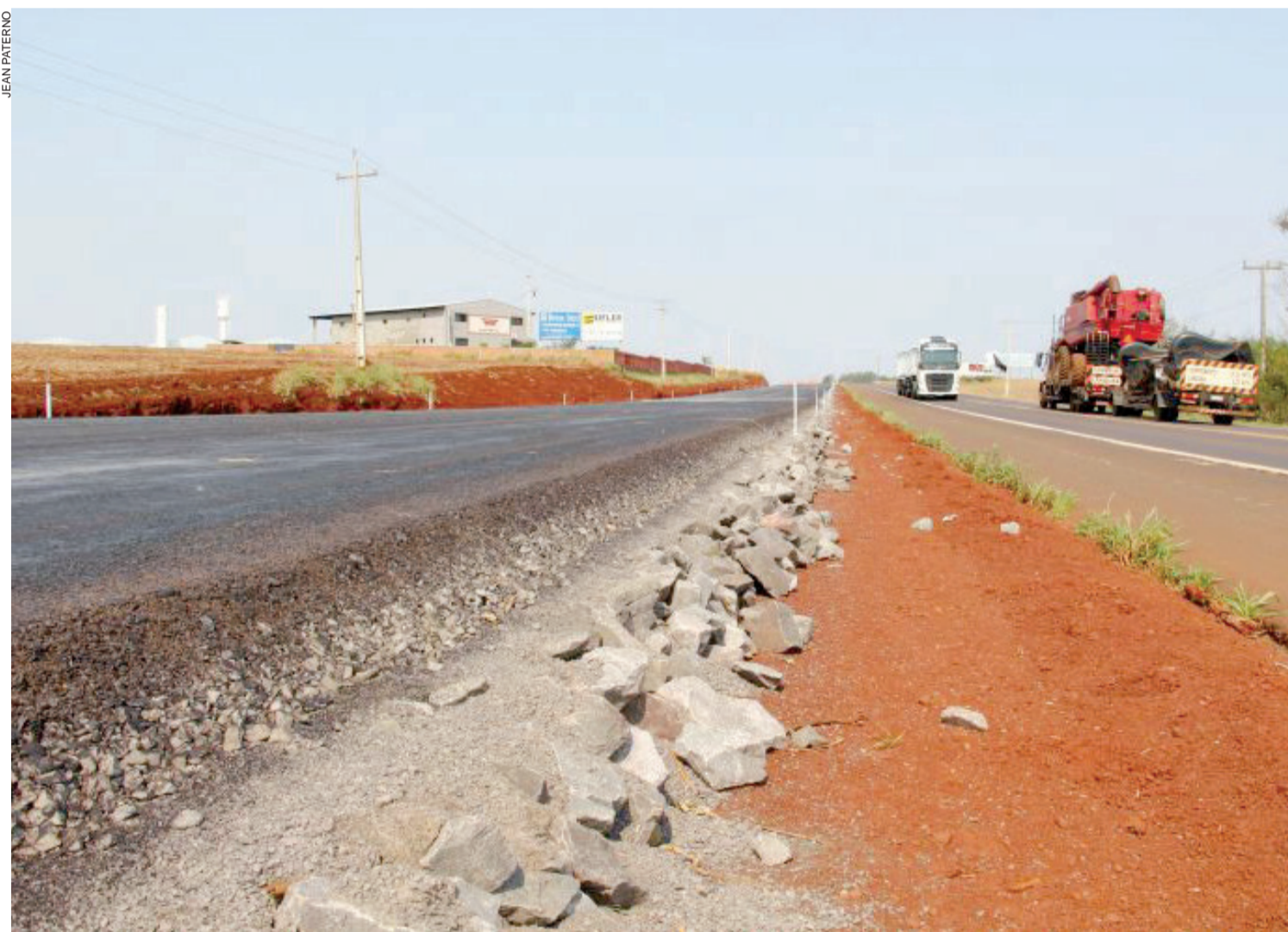
Trecho entre Toledo e Rondon tem quase 40 quilômetros e está orçado em R$ 306,5 milhões
