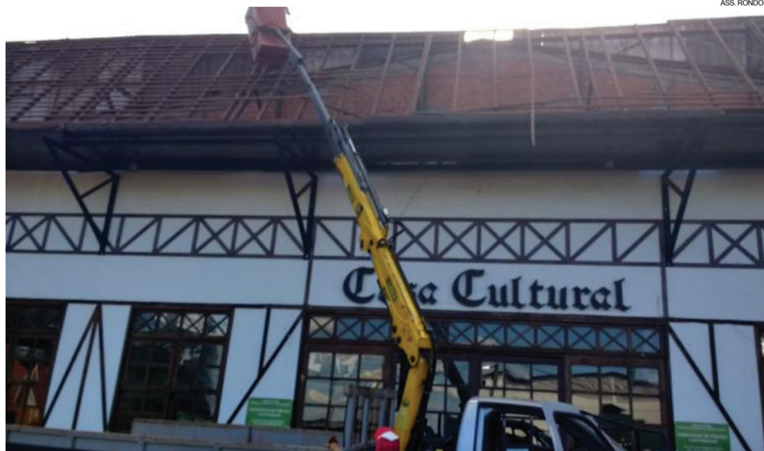
As obras de recuperação atendem a uma determinação do Corpo de Bombeiros
