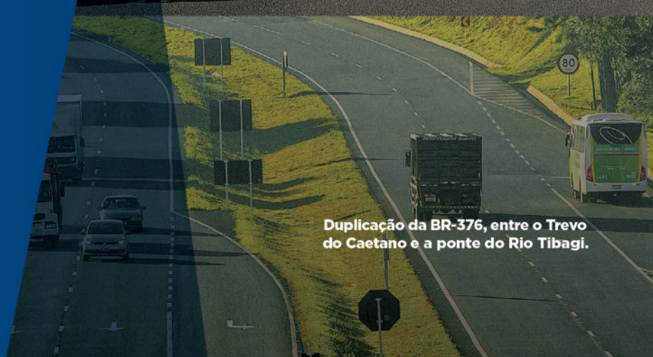
Recuperação e ampliação da Estrada do Cerne, entre Curitiba e Campo Magro.
