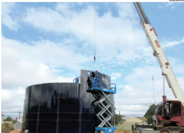
As 90 placas de aço vitrificado vão armazenar 660 mil litros de água em Cascavel
