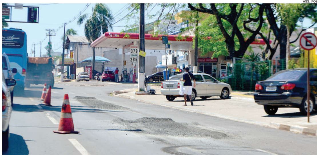
Obras compreendem fresagem do pavimento e colocação de massa asfáltica
