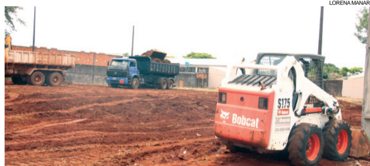
Equipes trabalhavam ontem para a limpeza da área entre as ruas Martin Afonso de Souza e Maringá
