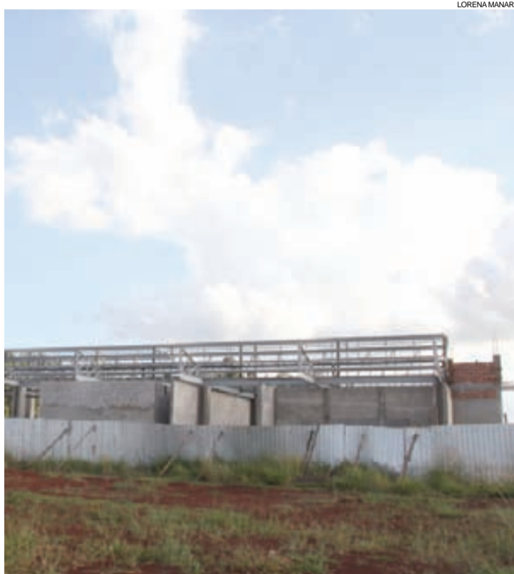
Em mais de dois anos, 34,44% das obras do Terminal de Passageiros do Aeroporto de Cascavel foram concluídas
